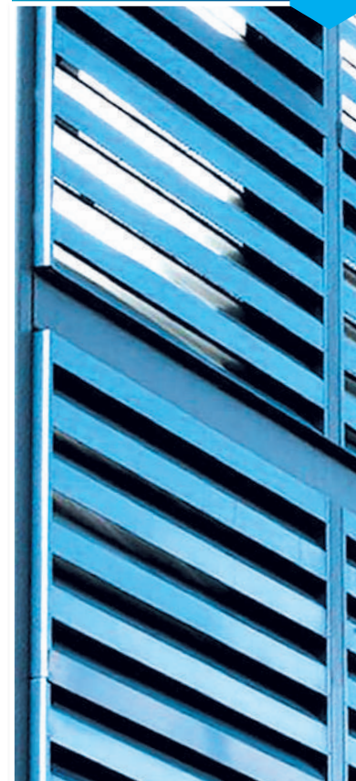
ФАСАД ПРОМЫШЛЕННОГО ЗДАНИЯ
