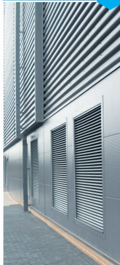
ФАСАД ПРОМЫШЛЕННОГО ЗДАНИЯ
